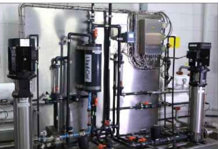
سیستم آبساز یکی از تجهیزات بسیار با اهمیت کارخانه می باشد. در حال حاضر انواع آب با گردیدهای مختلف مانند آب خالص (PW) آب مقطر تزریقی (WFI) تولید می شود.
